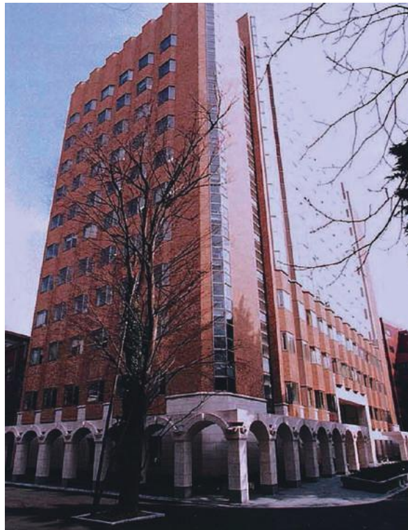
図：竣工直後の理学部新1号館・西棟。「理学部ニュース」1998年3月号の表紙(白黒)のカラー原版で、化学専攻の編集委員(当時)だった井本英夫氏が撮影したものを拝受した。新1号館の竣工記念パンフレットにも使われている。
